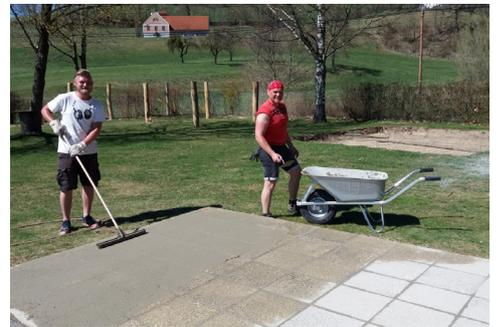
Der größte Teil der Betonplatten wurde herausgerissen, gereinigt und auf neuem Unterbeton neu verlegt und verfugt, Unebenheiten der Grünflächen perfekt ausgeglichen und gebnet.
