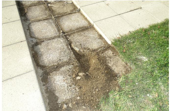
Über 25 Jahre Chlorwasser und Winterfrost haben den Platten bzw. dem Unterbeton der Beckenumrandungen und Verbindungswege arg zugesetzt. Schon mehrmals waren von der Bäderaufsicht Unebenheiten und offene Fugen beanstandet worden.
