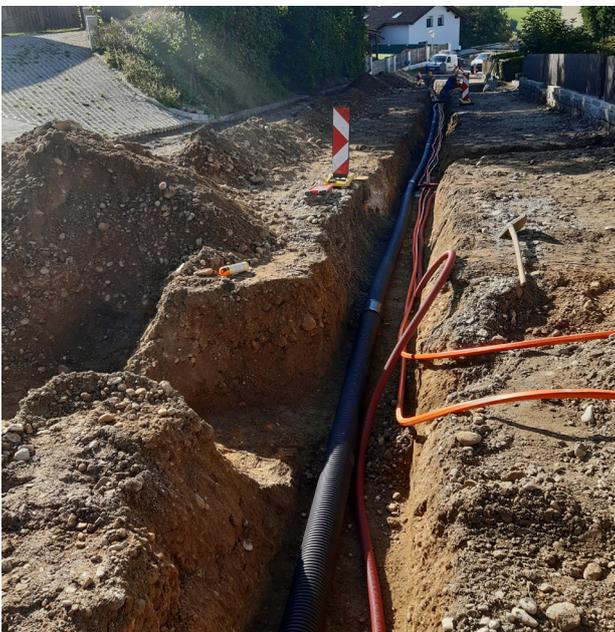
Im Zuge der Bauarbeiten wurde Glasfaserkabel, Kabel f. Ortsbeleuchtung und Leerverrohrung f. Ebner-Strom verlegt.
